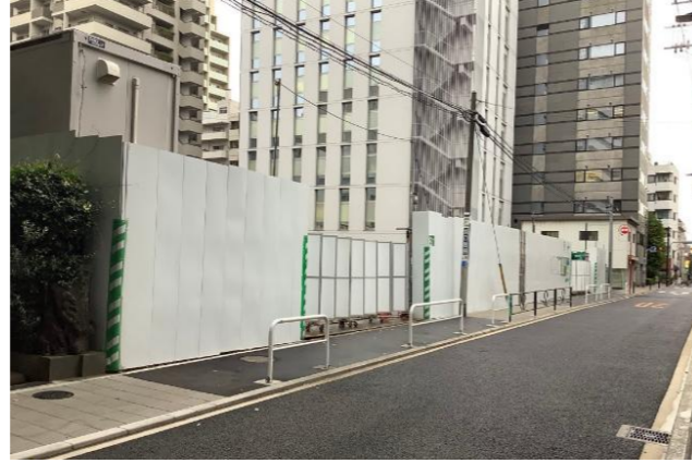
外部養生（仮囲い・ゲート）
