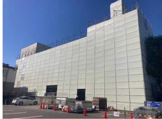
建物養生（防音パネル）
